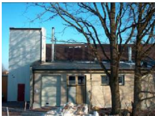
Figur 4: Pelletsfyrt varmesentral i nærvarmenett, Kirkebakken, Horten
