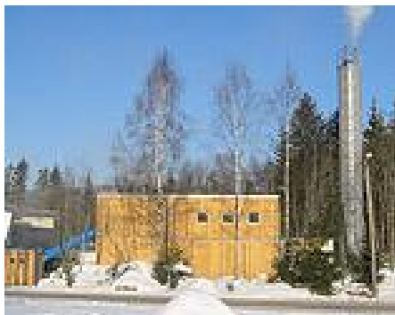
Figur 3: Flisfyrt varmesentral i fjernvarmenett, Nannestad
