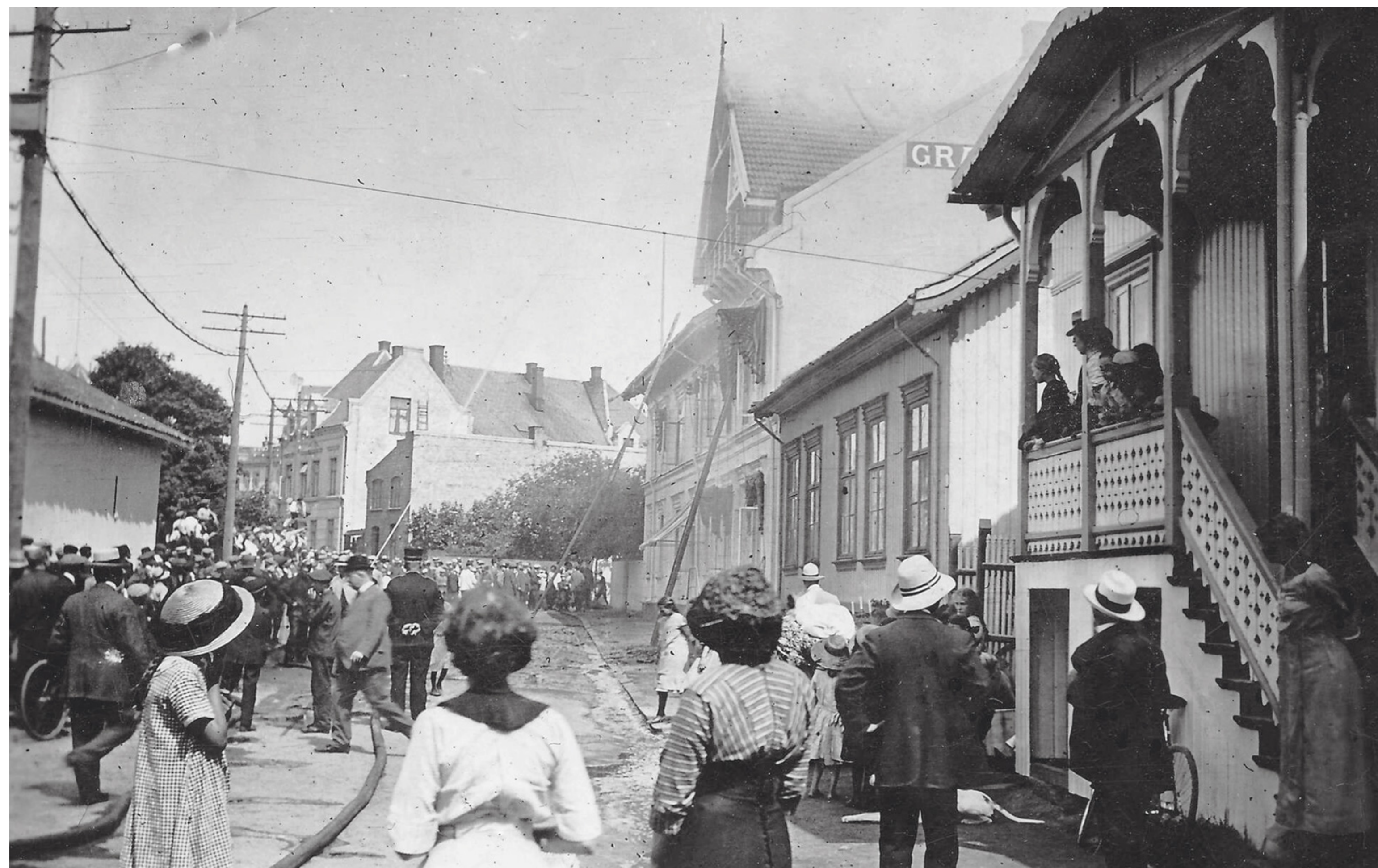
Grand Hotel brant i 1913. Bildet er tatt fra Torggata opp Skolegata. Til høyre, Torggata 5, hvor Pausteparken ligger i dag. Foto: Sandefjord brannvesen
