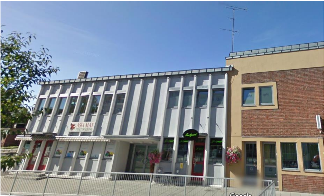
Figur 8-13 «Nye» Folkets hus (til venstre) er oppført på 1960-tallet, etter at det gamle Folkets hus (tidligere sosisetetsbygning til Sandefjord Bad) ble revet. Bygningen har arkitektoniske kvaliteter og er svært representativ for offentlig byggeri på 1960-tallet. Folkets hus reguleres «grovt» i planforslaget, blant annet tillates påbygging av bygningene. Bilde: Google Street View august 2022.
