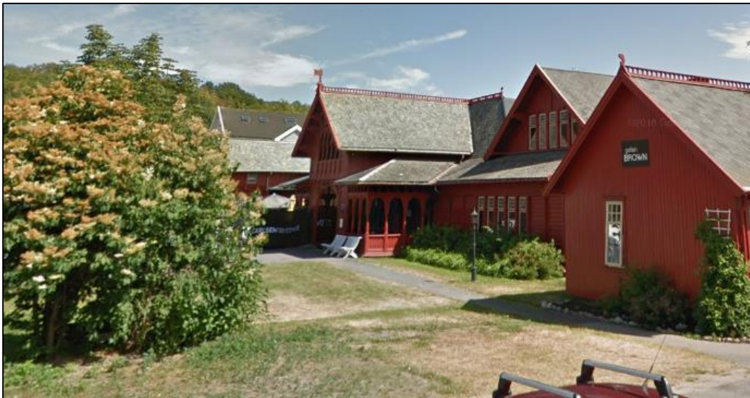
Figur 8-9 Kurbadsbygningen fikk sin nåværende form og dragestilsfader i 1899. Bilde: Google Street View, juli 2017.
