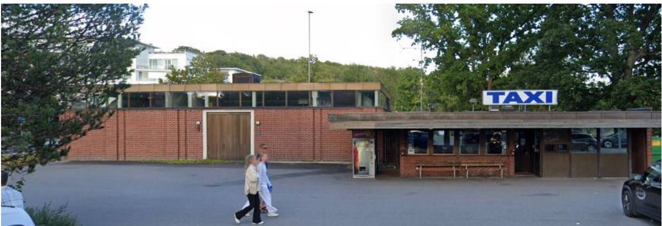
Figur 8-14 Pumpestasjon og Taxi-sentral er bygget som et enetasjes paviljongbygg, og har tydelige modernistiske stiltrekk og gode materialkvaliteter. Bygningene ligger midt i planområdet og rives/bygges inne som følge av planforslaget. Bilde: Google Street View august 2022.
