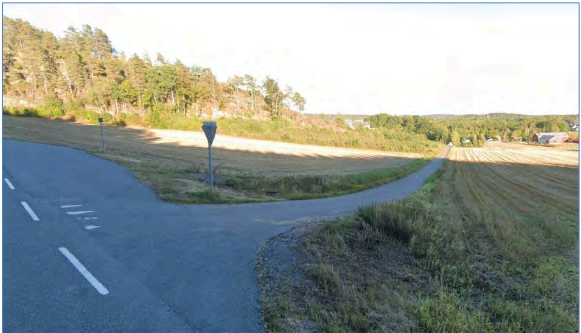
Figur 3: Adkomstvei er fra fylkesvei 303/Feenveien via Gleaveien. Bussholdeplass er vist til venstre
