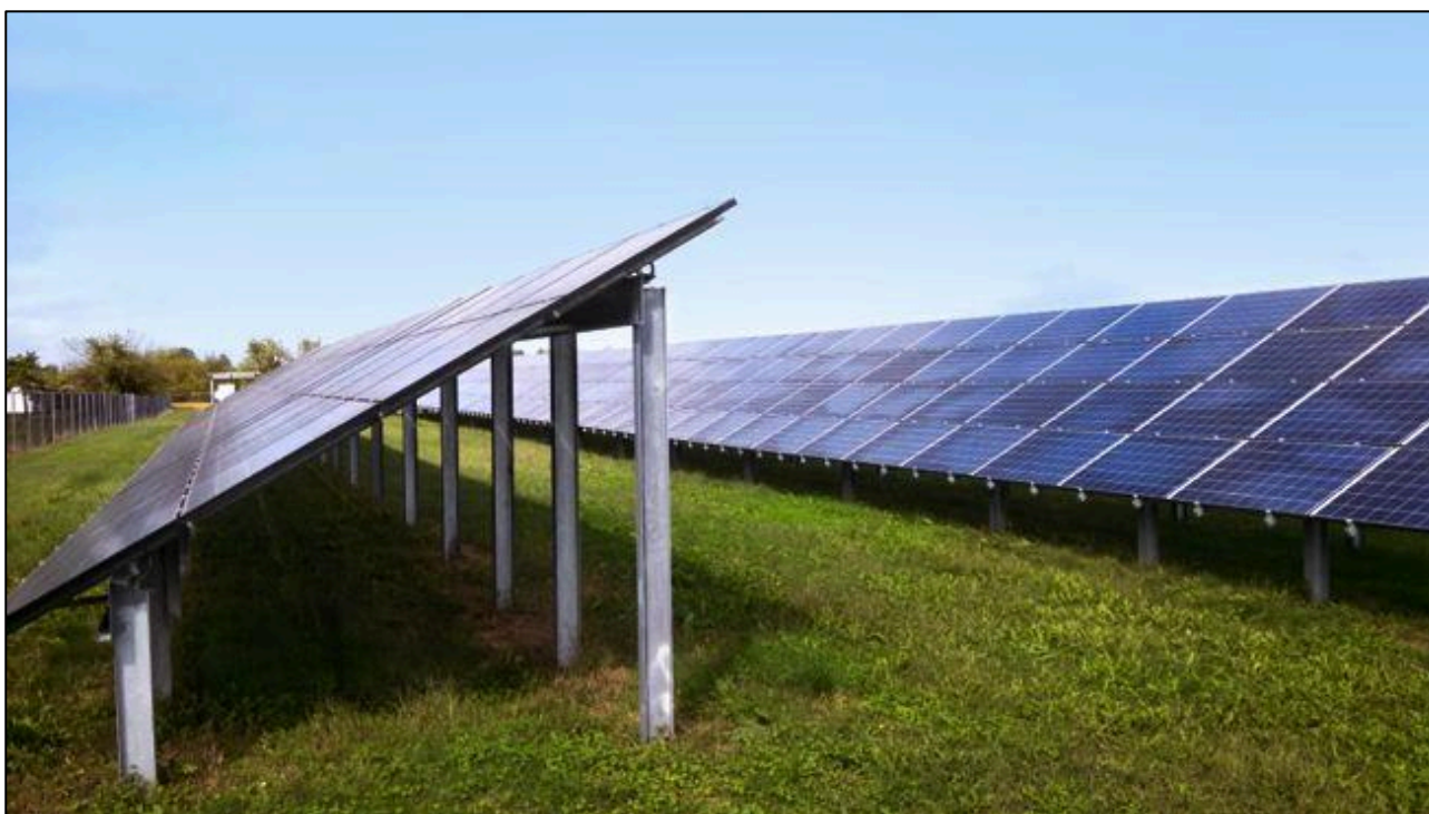
Figur 3-1: Fast-vinkel installasjonsløsning (foto: Willowbrook Solar).
