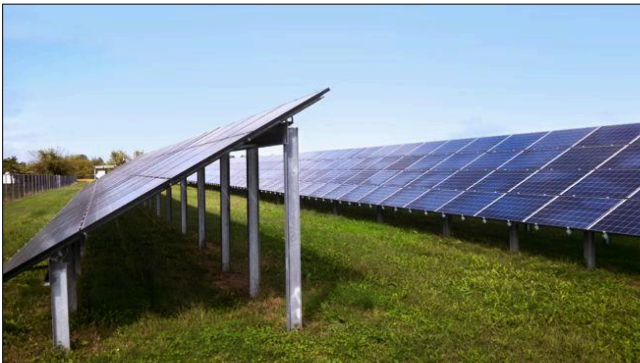
Figur 3-1. Fast-vinkel installasjonsløsning (foto: Willowbrook Solar).
