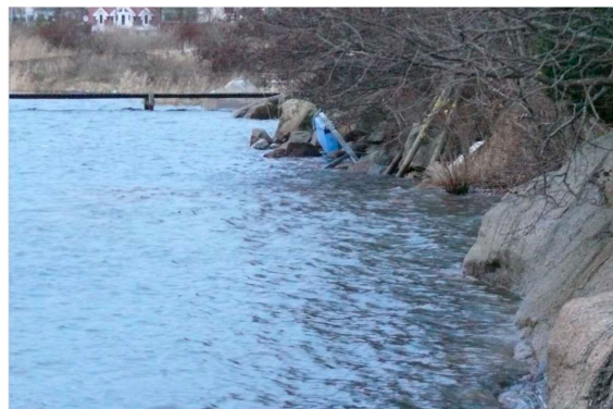
Figur 38 Bilde mottatt 5.3.23 i felles skriv fra grunneiere gbnr 111/498, 111/444 og 111/304. Bildetekst: Vannstand høy Asnesveien 7b sett mot nord.
