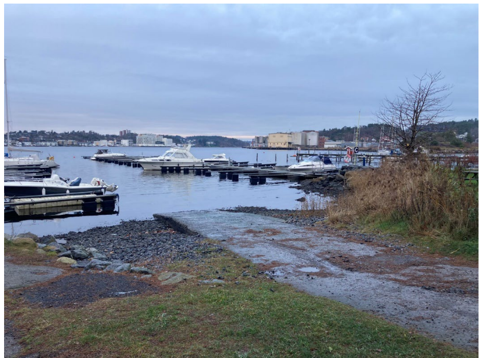
Figur 18 eksisterende rampe for utsetting av småbåter
