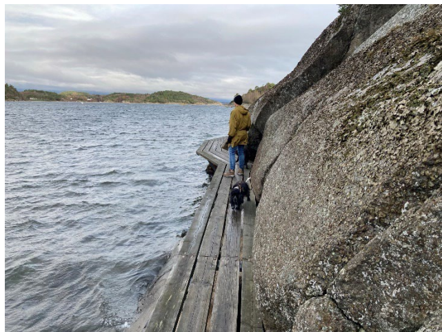
Figur 33 Eksempel på gangbane uten rekkverk, Truberodden - Østerøya
