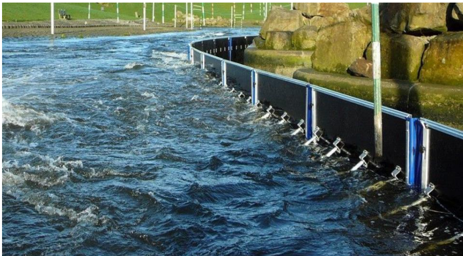
Figur 24. Installerte elementer (flomgjerde).
