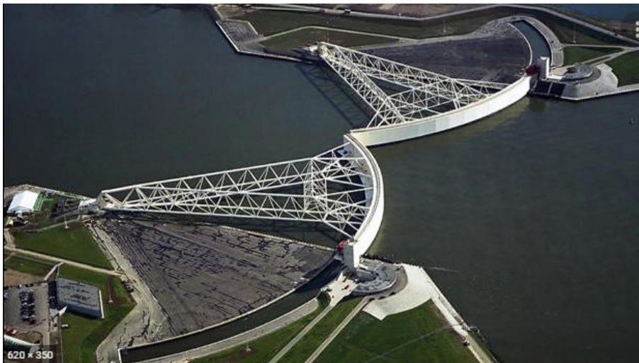
Figur 20. Flomsikring mot stormflo i Rotterdam.
