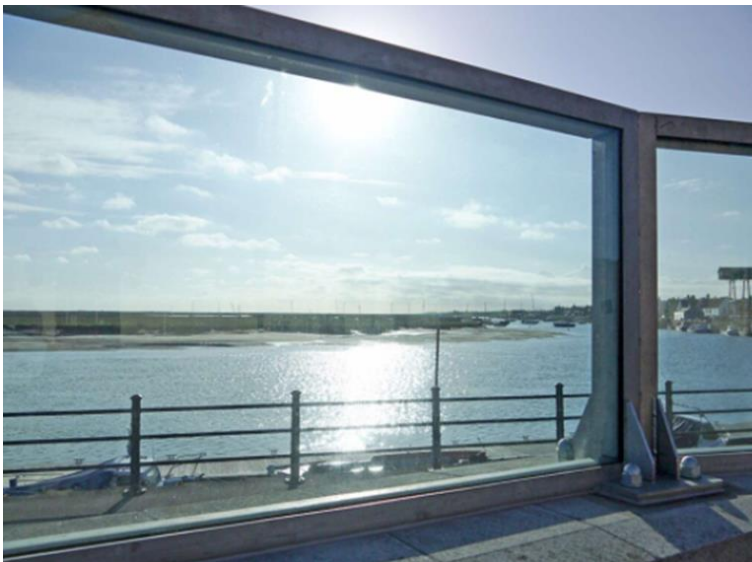
Figur 18. Flomsikring med glassgjerde.
