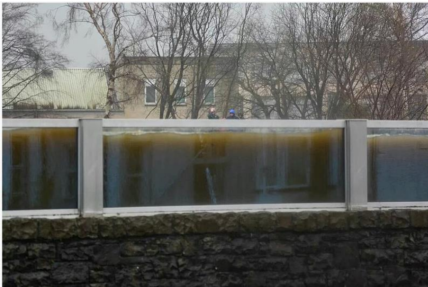
Figur 19. Flomsikring med glassgjerde 2015 flom (Keswick England).
