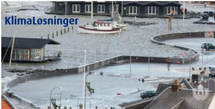
Figur 17. Betongmur Lemvig (etter COWI design).
