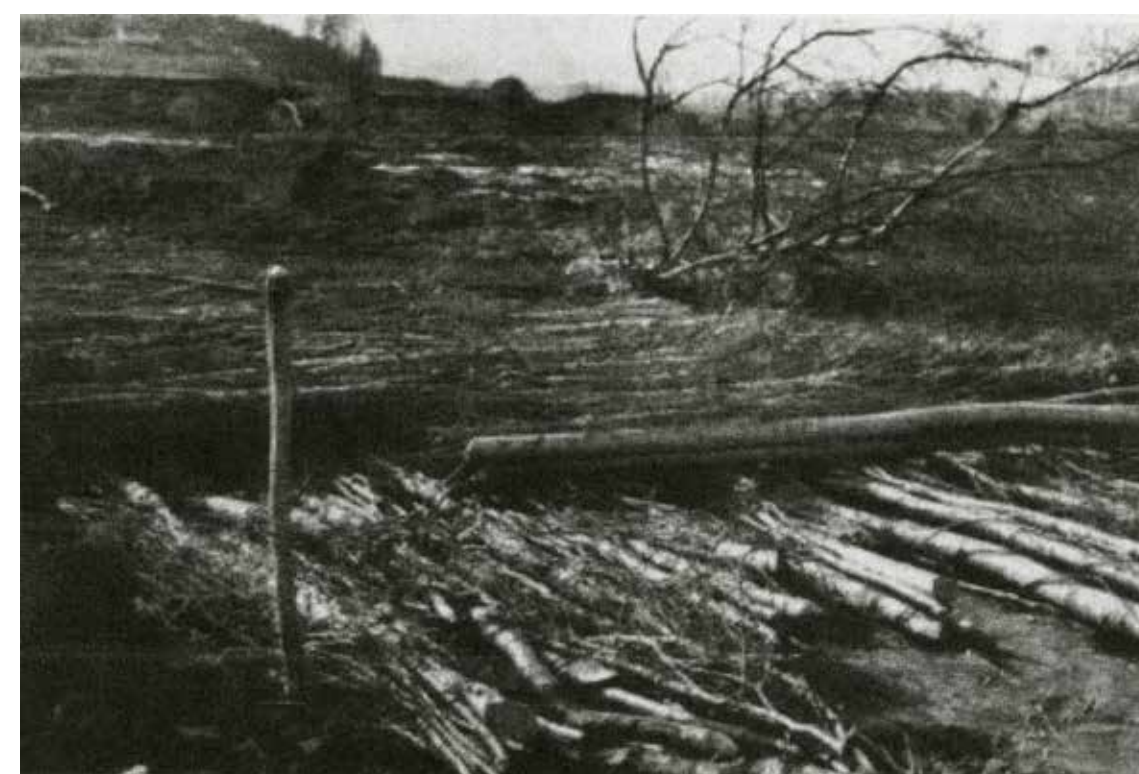
Tømmerstokkene (faskinunderlaget) som ble brukt som provisorisk vei i flere år. Foto: Gunnar Holmsen.
