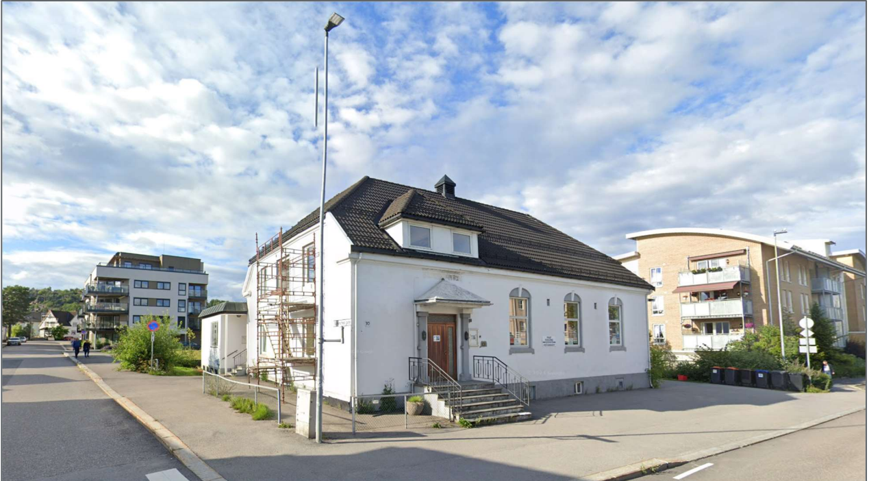
Figur 3: Eksisterende bebyggelse på tomte. Bygg i to etasjer samt bod på en etasje. Bygget huser pt. NAV Sandefjord.
