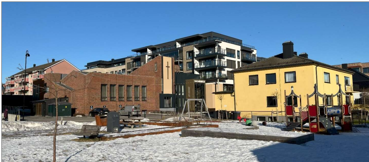
Figur 5: Eksisterende lekeplass på tomte. Standpunkt er i lekeplassen vendt nord-øst mot nabotomt.
