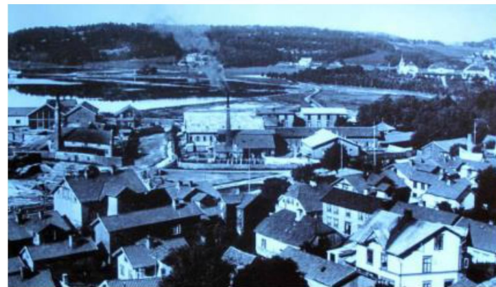
Kystlinja før mudring og bygging av Hesteskoen
