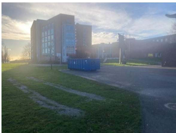
Eksempel på kjøreskader og uheldig utbedring. Her er det kun fylt på grus.
